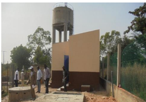
Centre de traitement de l'eau potable réhabilité - Animadè dans la région de la Kara
