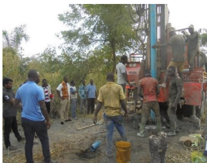
Nouveau forage en cours d'installation à Wahala dans la région des Plateaux
